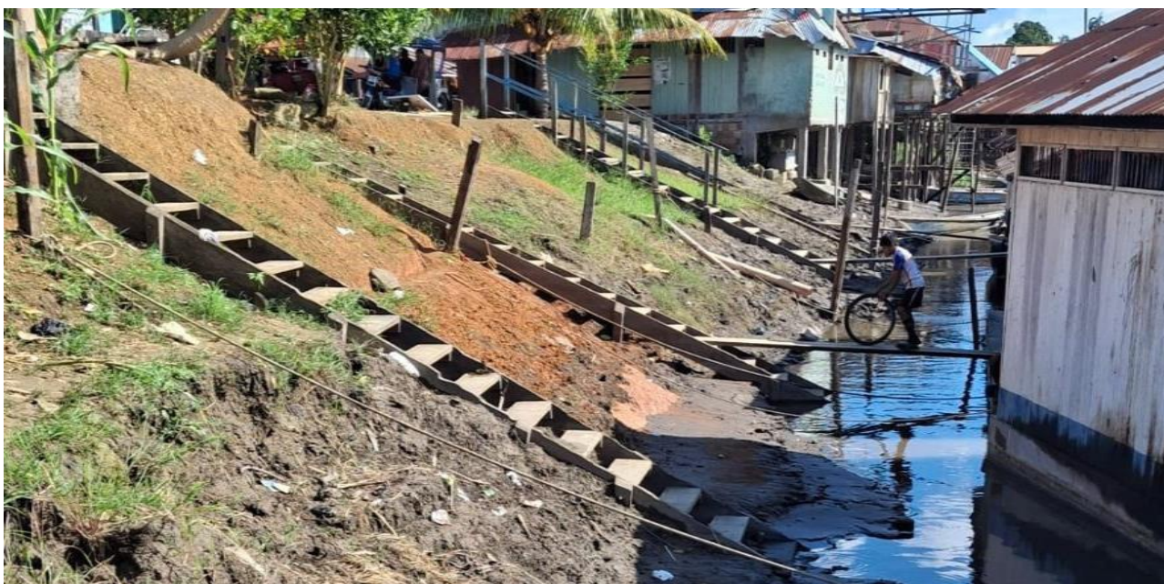
FIGURA N°02: GRADAS PEATONALES DE EMBARQUE Y DESEMBARQUE EXPUESTAS A LA EROSIÓN FLUVIAL.
